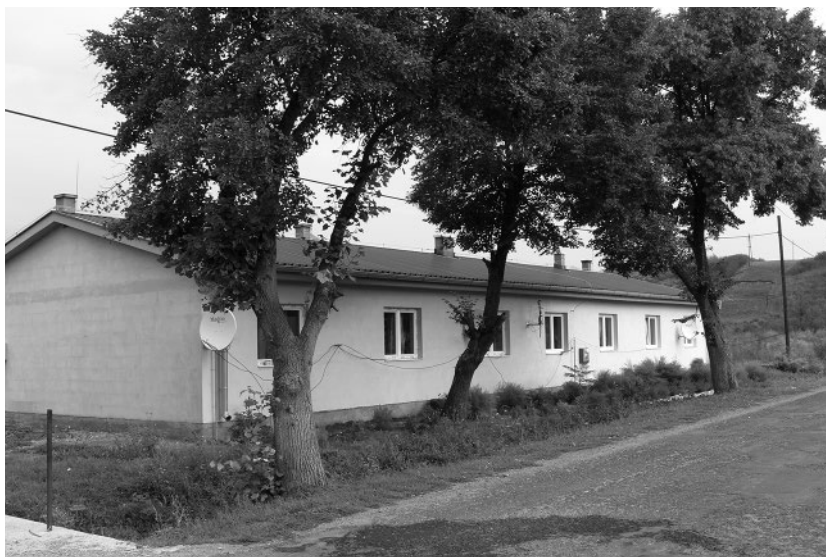
Domy socjalne dla Romów, Pavlovce, 2012 (fot. O. Bodorová)
